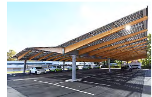
Solar-Carport über Parkdeck
