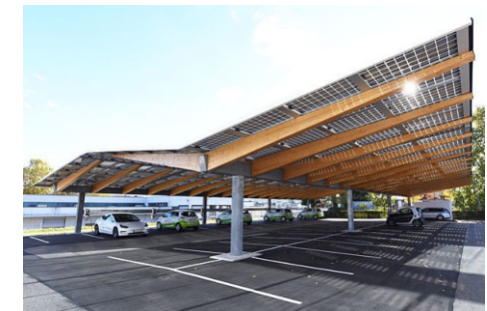
Solar-Carport über Parkdeck
