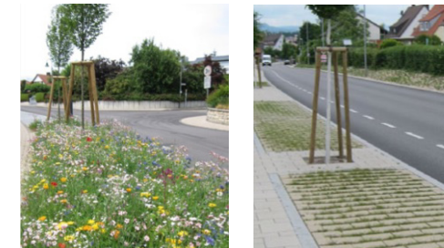
Wäschenbeuren – Bepflanzung Fahrbahnrand Versickerungsfähige Beläge
